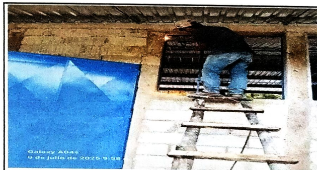
Foto 6: Se observa la puerta instañada y la instalacion de ventanales
