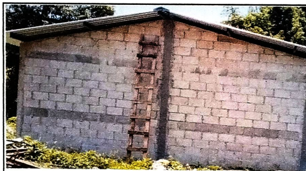
Foto 4: se indentifica el avance de la instalacion de pared frontal
