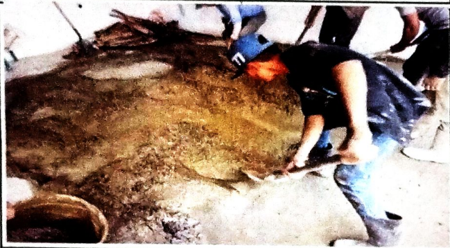
Foto 1: se indentifica el avance de la rehabilitación de aula, es necesario por la seguridad de los niños como tambien para que reciben clases sin pausa
