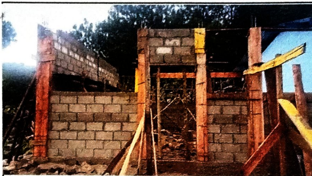
Foto 2: como se muestra en la fotografia el avance del levantado de block,
