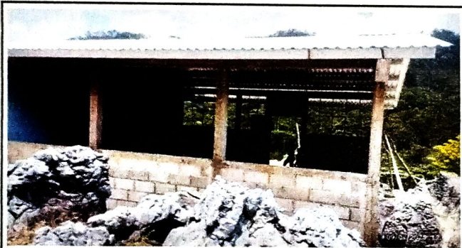
Foto 3: Se observa el avance de la instalacion de laminas troqueladas calibre 26 aluzinc
