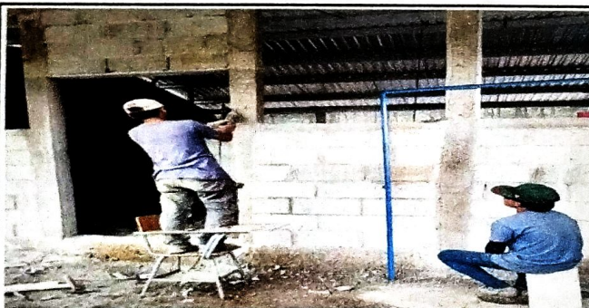
Foto 5: Se evidencia el avance de la instalacion de base de de metal para la puerta del Centro Educativo
